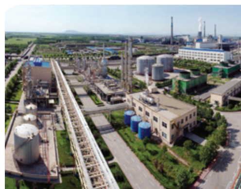
Dingzhou production base 定州生產園區
